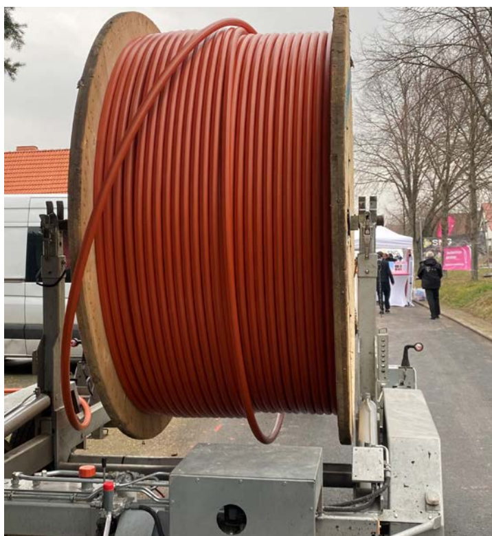
Glasfaserkabel für Bad Salzungen
